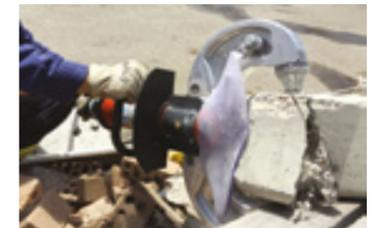
Eine perfekte Kombination: Beton mit dem CC 23 wegbrechen und Betoneisen mit dem Minischneidgerät CU 4007 oder SMC 5006 schneiden.
